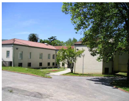
Edificio: Zubiría Etxea
