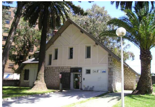
Edificio: Basoko Etxea
